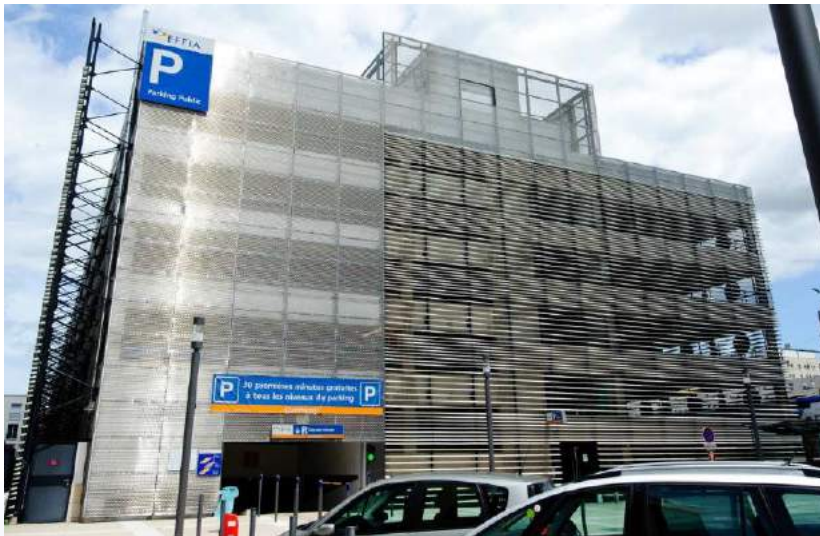
Exemple du parking silo de la Gare de Reims
