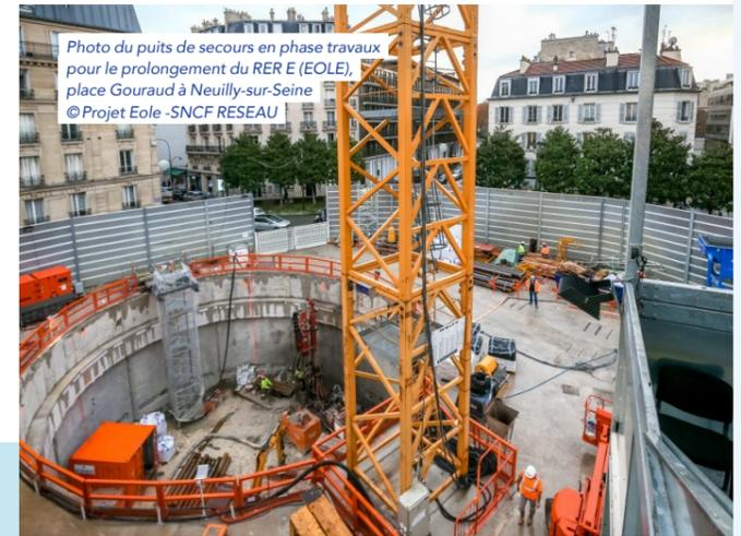
Photo du puits de secours en phase travaux pour le prolongement du RER E (EOLE), place Gouraud à Neuilly-sur-Seine ©Projet Eole - SNCF RESEAU
