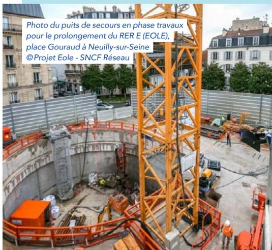
Photo du puits de secours en phase travaux pour le prolongement du RER E (EOLE), place Gouraud à Neuilly-sur-Seine © Projet Eole - SNCF Réseau
